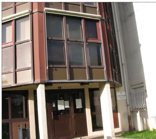
La démolition de cette résidence pourrait intervenir dans moins d'un an.
